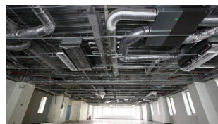
空調ダクトを清掃したい
